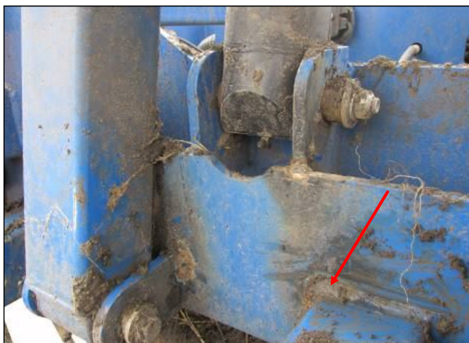
Рисунок А.2 – Сварка по месту разрыва (по сварному шву) центральной рамы
