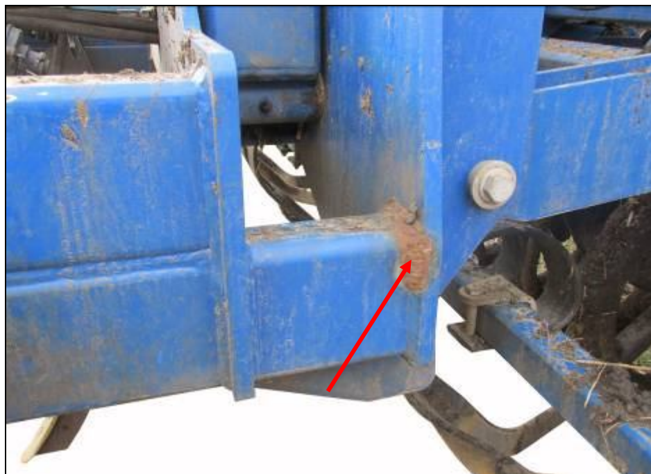
Рисунок А.1 – Сварка по месту разрыва (по сварному шву) центральной рамы
