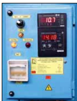
Шкаф управления, общий вид
