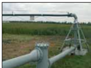
Неподвижная опора дождевальной машины
