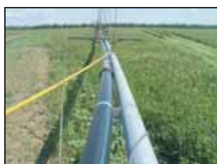
Полиэтиленовый и стальной трубопроводы
