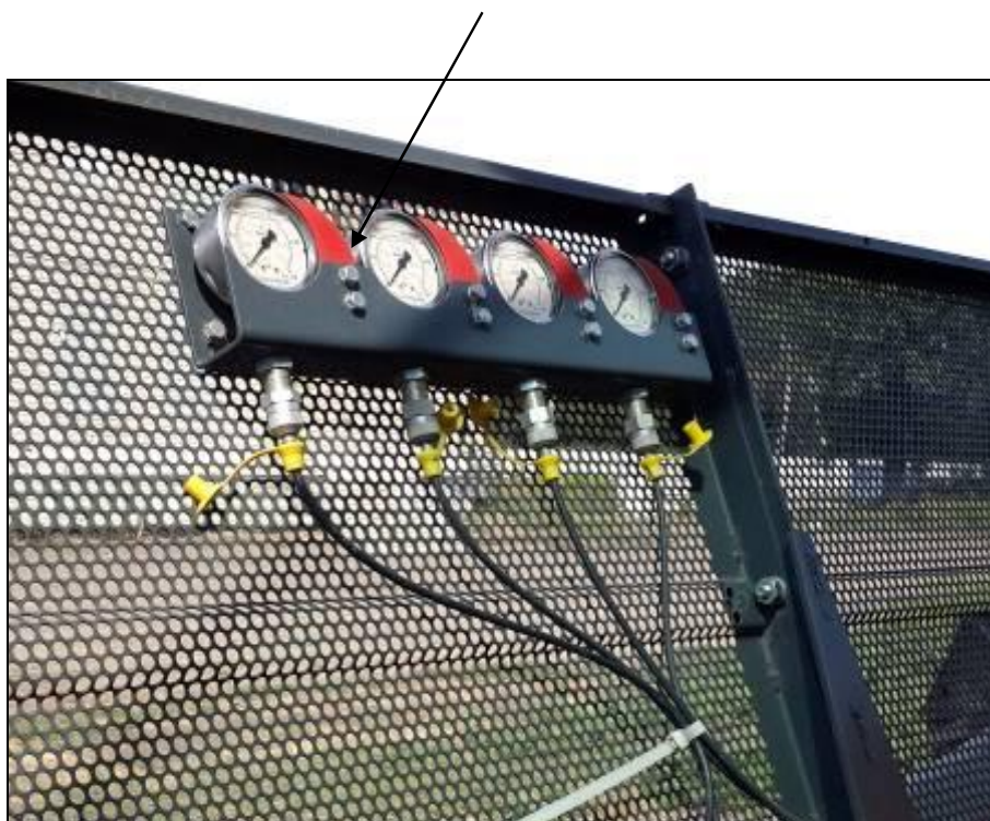
Рисунок 7 – Блок манометров для отслеживания давления в контурах гидравлической системы
