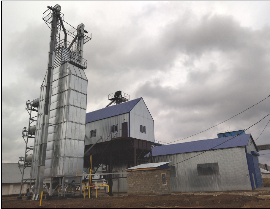
Рисунок 2 – Зерносушилка модульная жалюзийная FLATUM 7-8, в работе (на сушке зерна подсолнечника)
