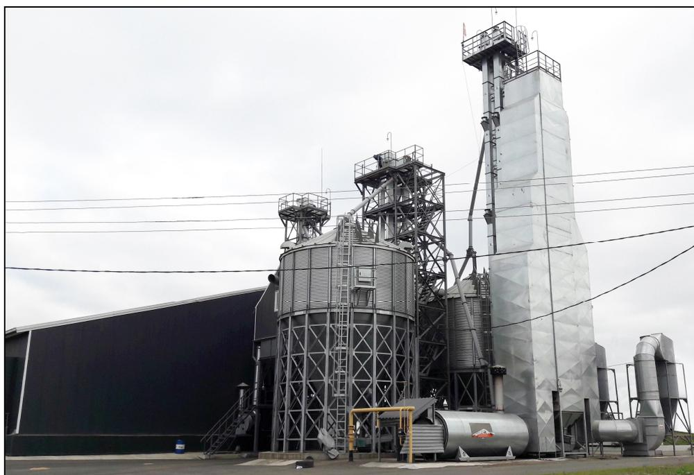
Рисунок 1 – Сушилка зерновая шахтная модульная типа "С" С-40 "Стандарт" с косвенным типом нагрева, вид топлива газ, вид спереди слева
