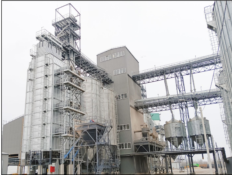
Рисунок 2 – Сушилка для послеуборочной сушки зерна перед закладкой на хранение типа СВМ модель СВМ 8-16 в составе зерноочистительно-сушильного комплекса, в работе
