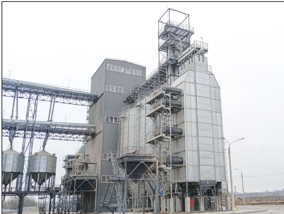
Рисунок 1 – Сушилка для послеуборочной сушки зерна перед закладкой на хранение типа СВМ модель СВМ 8-16, вид спереди слева
