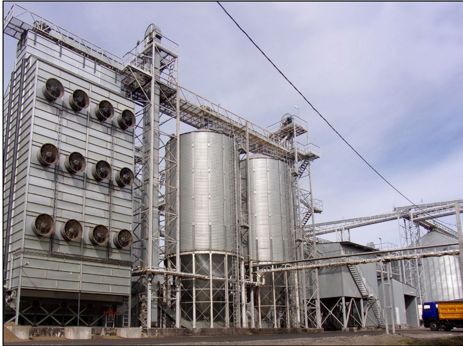
Рисунок 2 – Сушилка шахтная с рекуперацией серии S, модель S16-28 в составе зерноочистительно-сушильного комплекса, в работе
