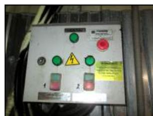
Ящик управления с пусковой аппаратурой
